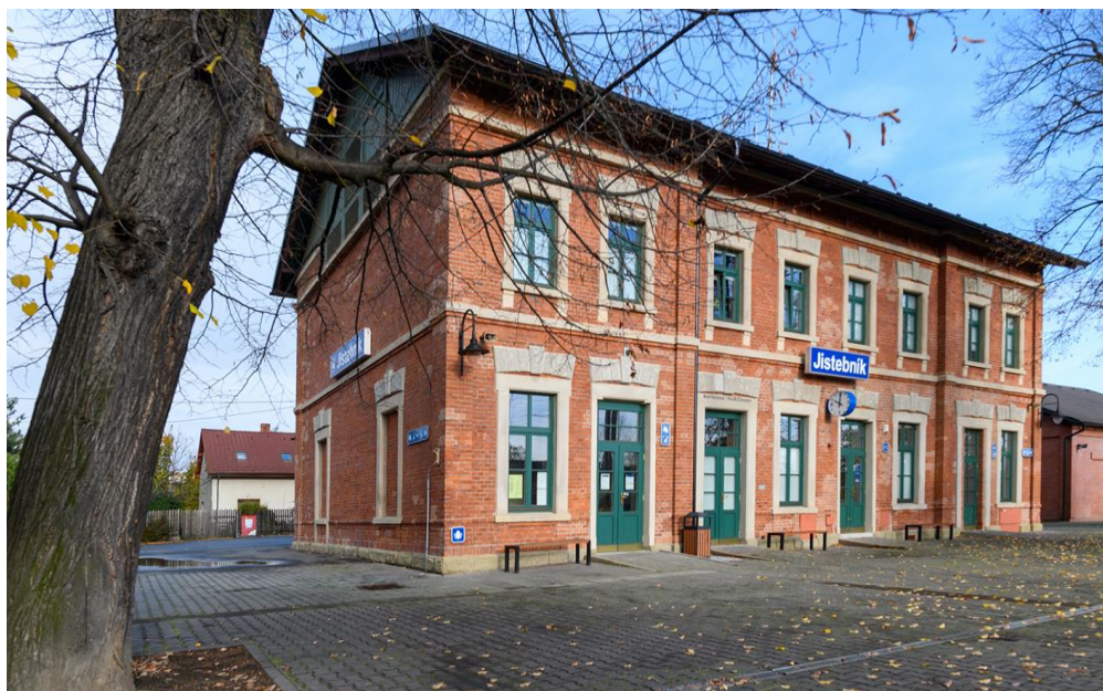
Obrázek č. 4: Budova nádraží v obci
